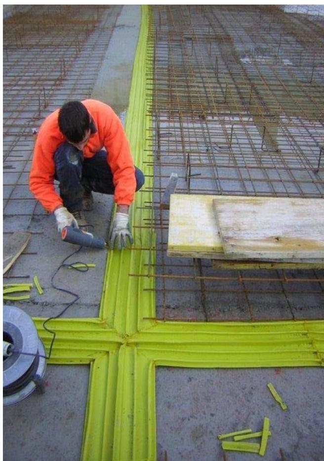
Figura 5. Realizzazione della platea. Dettagli giunti.
